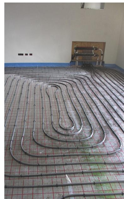
Le singole unità immobiliari sono dotate di impianti di climatizzazione a pannelli radianti, integrati nella pavimentazione mediante massetto anidritico (Montanari Costruzioni).
