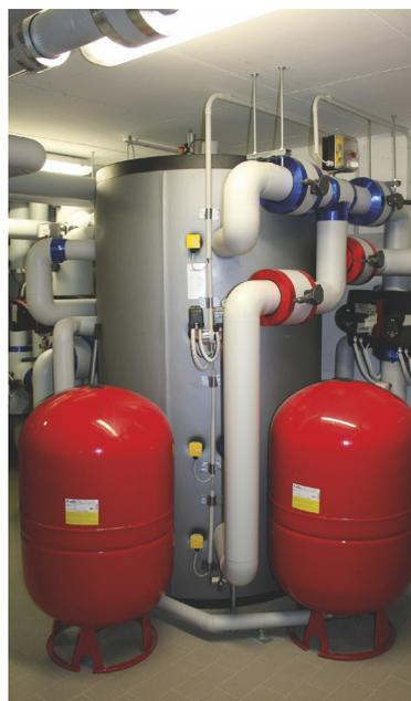
La produzione di ACS è affidata a un bollitore da 2.000 l, alimentato dal recupero termico attuato sulle pompe di calore destinate alla climatizzazione (Montanari Costruzioni).
