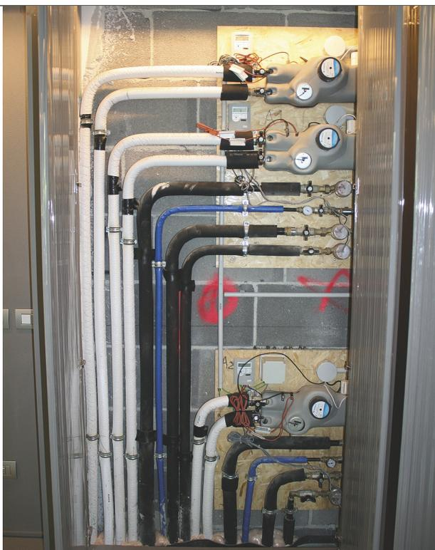
I montanti delle reti impiantistiche percorrono cavedi interni al blocco scala-elevatori, accessibili per le attività di manutenzione mediante semplice apertura delle ante metalliche (Montanari Costruzioni).
