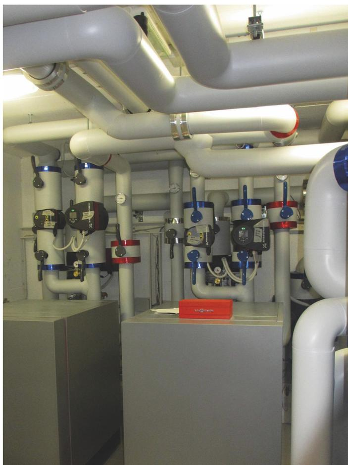
La centrale termofrigorifera è basata su 2 pompe di calore reversibili per riscaldamento e raffreddamento, collegate a un campo geotermico formato da 8 sonde verticali a circuito chiuso (Montanari Costruzioni).
