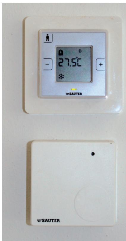
Uno dei terminali del bms Sauter, decisamente mininvasivi rispetto all'architettura degli interni; la temperatura evidenziata nel display è stata rilevata nel luglio scorso, con impianti disattivati, attorno a mezzogiorno.
