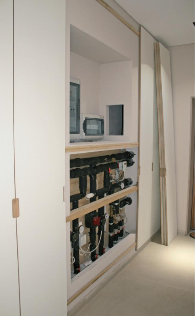
Le reti di distribuzione di Palazzo Bellotti sono alloggiate negli spazi connettivi comuni, chiusi da pannelli d'arredo: i sistemi Sauter sono alloggiati all'interno della scatola in alto, a destra, a fianco del foro del cavedio.
