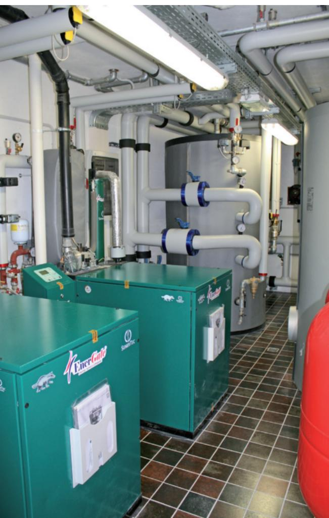
La centrale tecnologica di Palazzo Bellotti: in primo piano i microgeneratori, sullo sfondo i serbatoi inerziali; i terminali di produzione Sauter sono riconoscibili dai classici coperchi di colore giallo.
