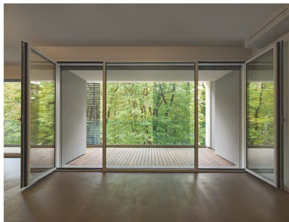
La presenza del verde è una costante nelle vedute dagli ambienti interni: la scelta di vetrate a bassa emissività garantisce un elevato gradiente luminoso e condizioni ottimali di comfort termico (Montanari Costruzioni).
